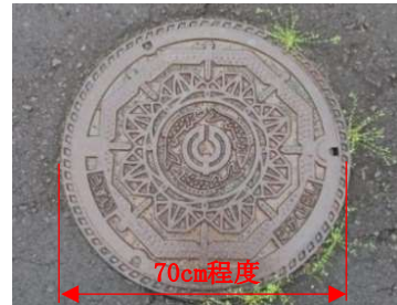
雨水マンホール（組立）
