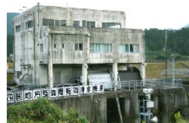
有岡排水機場
