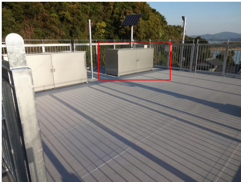
既存ライフジャケット収納箱移設（屋上から 3 階フロアへ：1 基）
