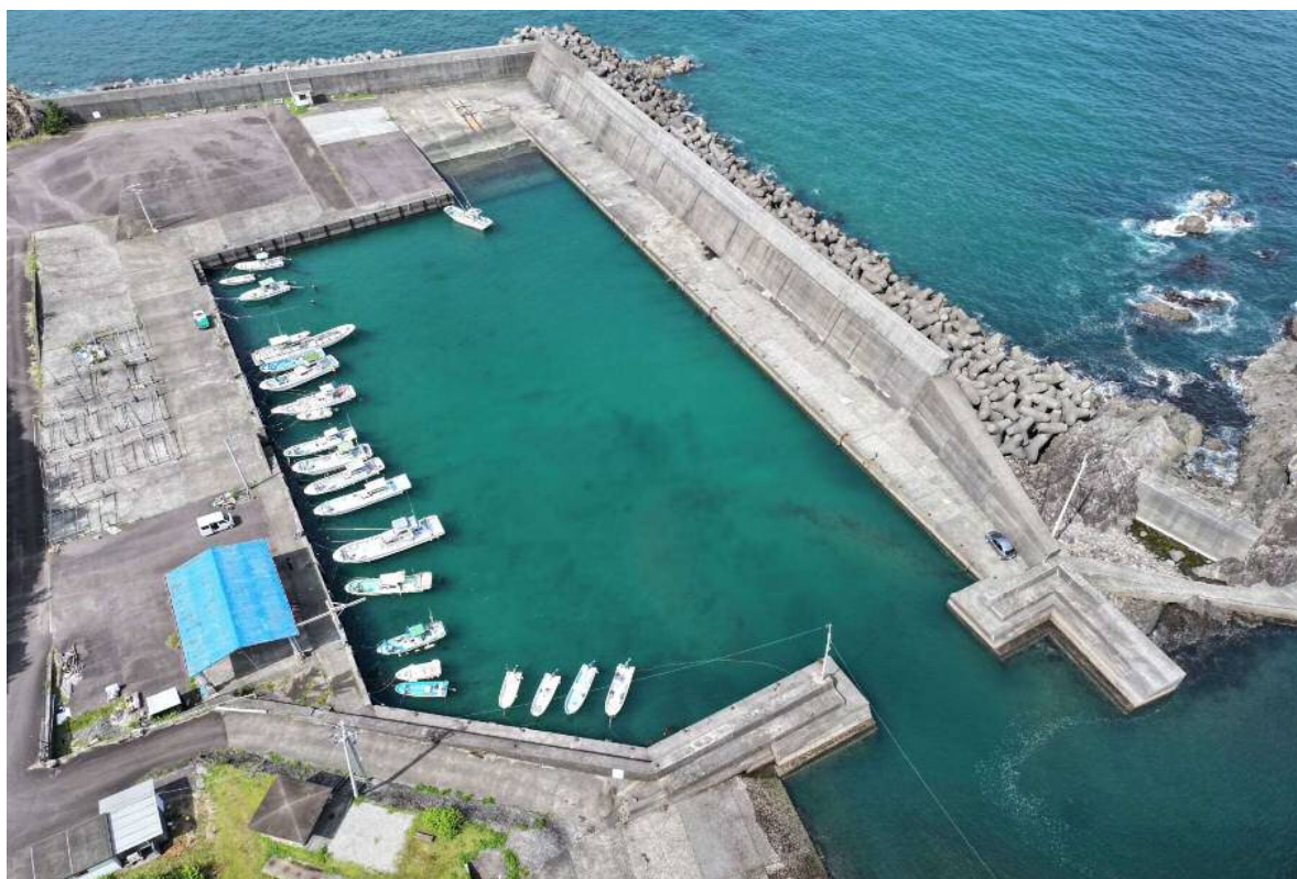
全体写真（南側から北側望む）
